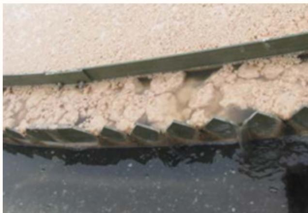
**Решение** – контроль концентрации **N** и **P**, применение программы биоаугментации **Биопродукт 200 + Биопродукт М100**
